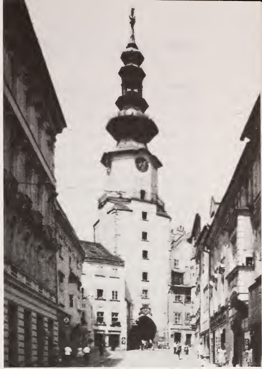
Michalská Tower, Bratislava
